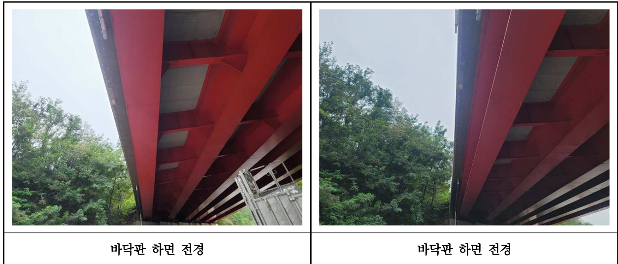
【사진 4.3.2】 바닥판하면 전경
