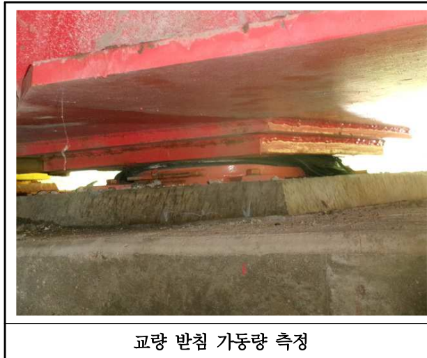
【사진 4.3.35】교량받침 이동량 측정
