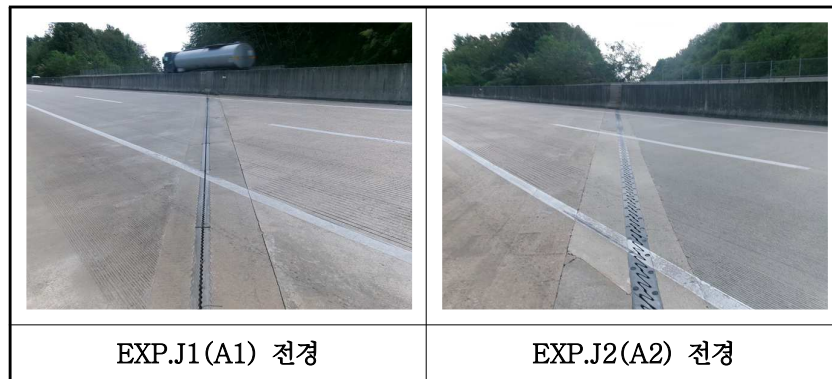
【사진 4.3.14】 신축이음장치 전경
