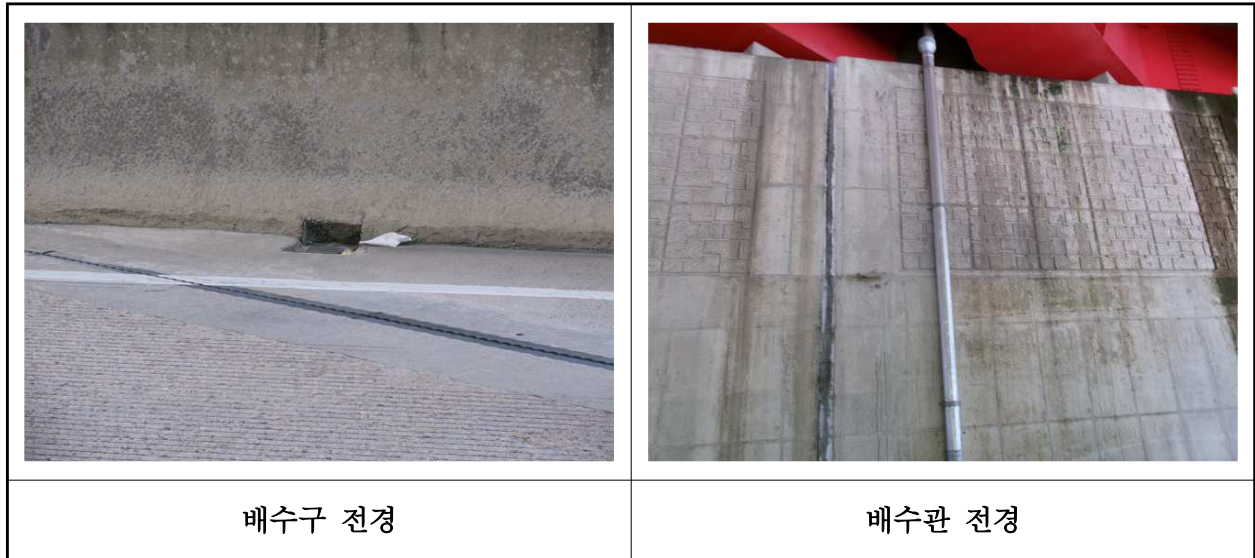
【사진 4.3.41】 배수시설 전경
