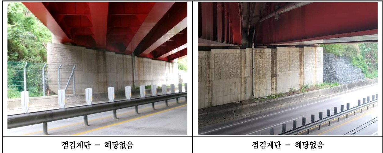
【사진 4.3.23】 교량 점검시설 전경
