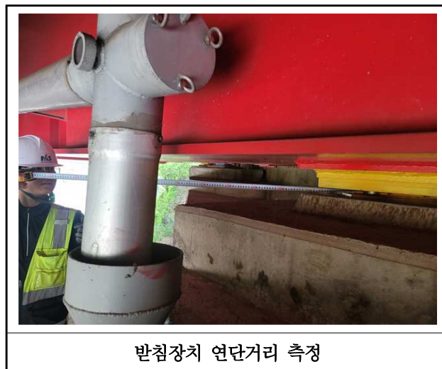
【사진 4.3.34】 교량받침장치 연단거리측정
