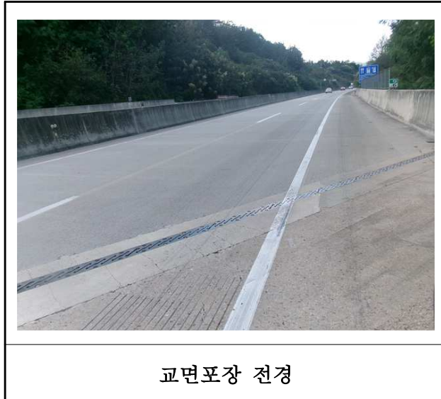
【사진 4.3.17】 교면포장 전경
