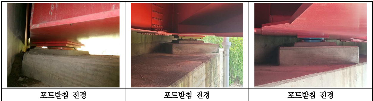
【사진 4.3.10】 교량받침 전경
