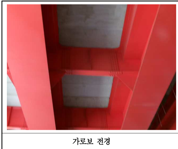
【사진 4.3.28】 가로보 전경
